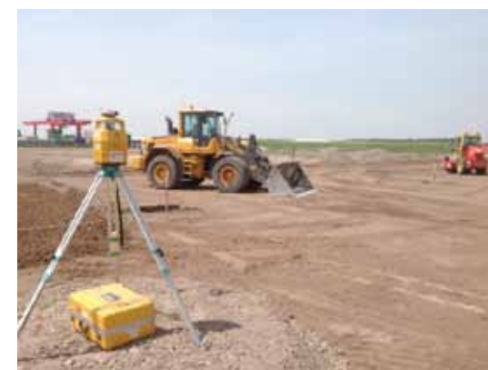
De draagkracht van de bodem wordt gerealiseerd door enkele verdichtingslagen
