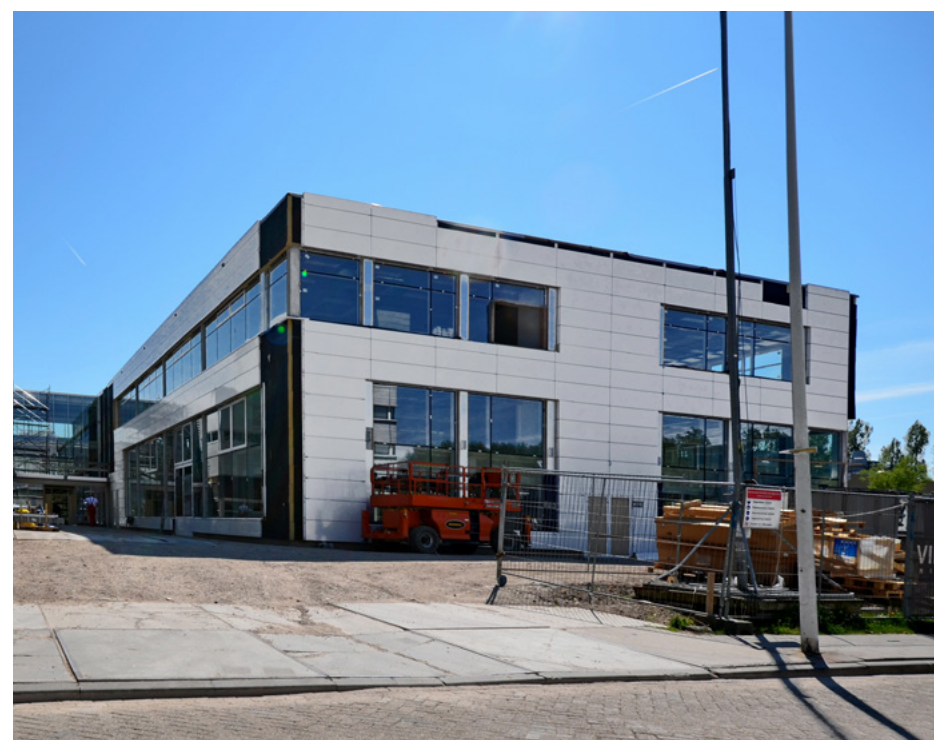
Een tussendeel met daarin de nieuwe hoofdingang verbindt de bestaande school met de uitbreiding
