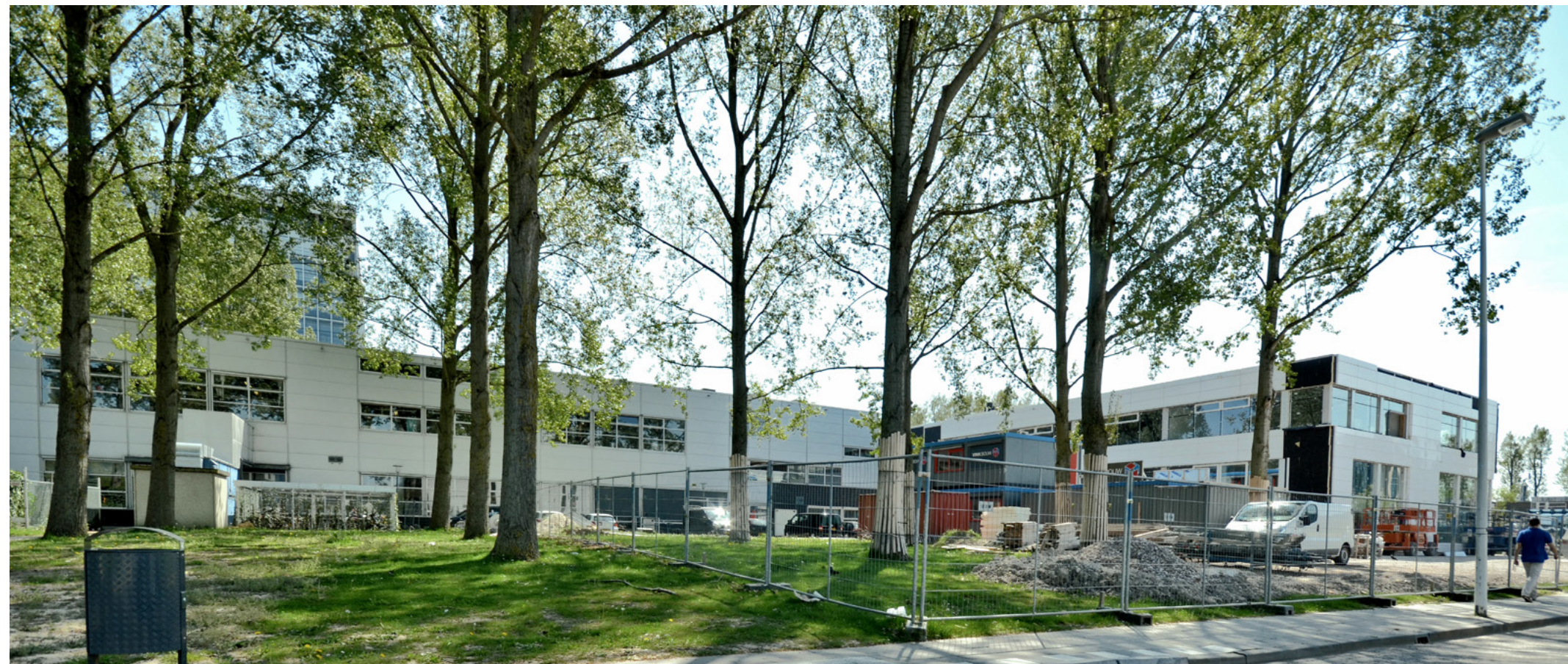
De school blijft gewoon open met zo min mogelijk overlast van de bouwwerkzaamheden
